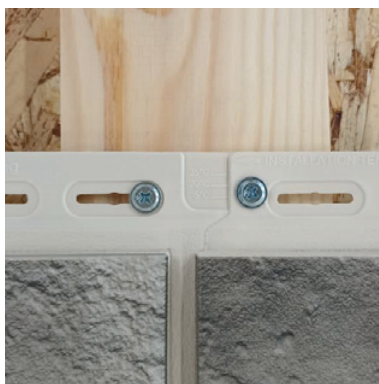
Саморезы в тело материала и край перфорации.
