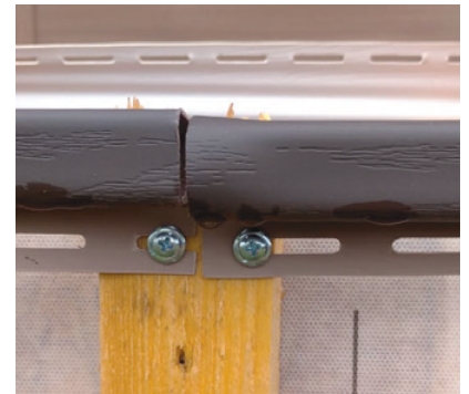
Неверное соединение J-профилей. Саморезы вкручены в края перфорации
