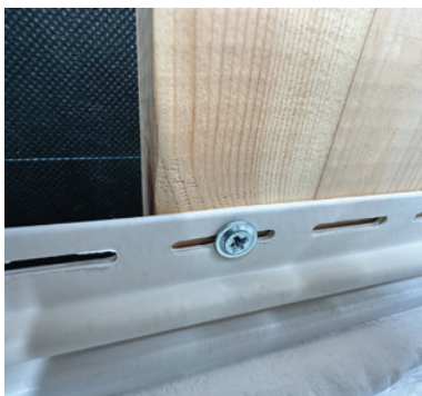
Саморез перетянут, панель неподвижна
