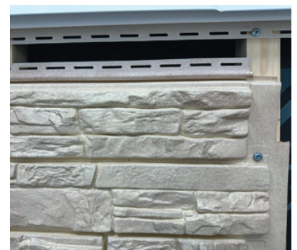
Саморез вкручен в тело панели, панель неподвижна
