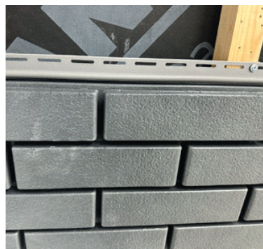
Панель закреплена в распор, неподвижна
