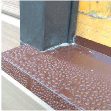
*Нет зазора между доборным элементом и металлическим отливом.*
