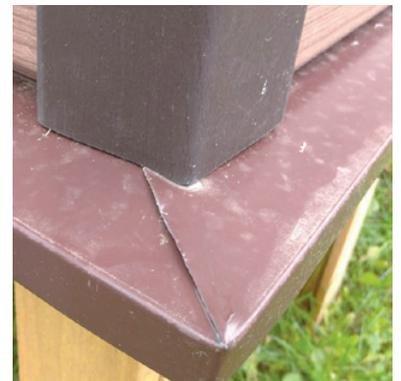
*Нет зазора между доборным элементом и отливом.*
