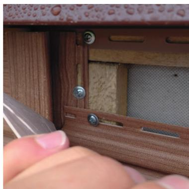
Саморезы вкручены в тело доборного элемента и края перфорации. Отсутствует зазор между шляпкой самореза и доборным элементом. Перекрыт вентиляционный канал.
