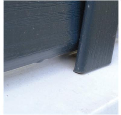
*Нет зазора между доборным элементом и металлическим отливом.*
